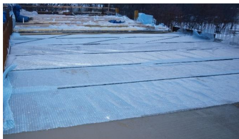
Rys. 2. Osłonięcie powierzchni wykonanego elementu za pomocą folii bąbelkowej, (fot. K. Owczarska).
