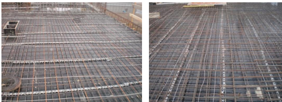
Rys. 9 i 10. Instalacja elektonagrzewu dla omawianego stropu kondygnacji +4, (fot. K. Owczarska).
